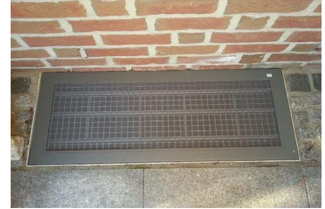
Das Sicherheitsgitterrost HERO Protect gibt es auch in der Variante Protect Plus mit integriertem Laub- und Insektenschutz. Natürlich ebenfalls nach RC3 getestet!!!
