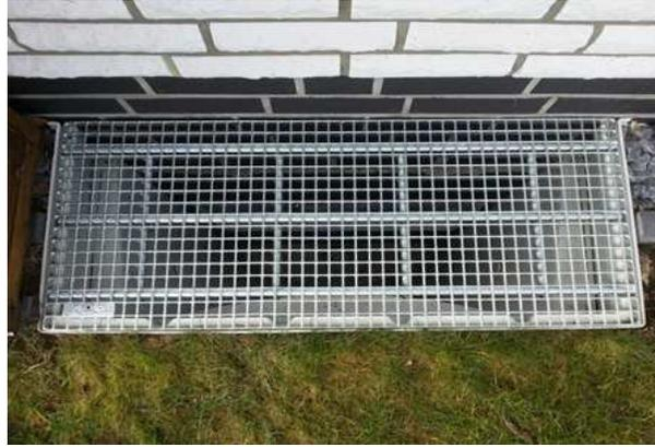
Kreuzpunktverschweißtes Gitterrost mit integrierten 15mm Rundstählen, diese können weder mit Bolzenschneider noch mit anderen üblichen Werkzeugen durchtrennt werden.
